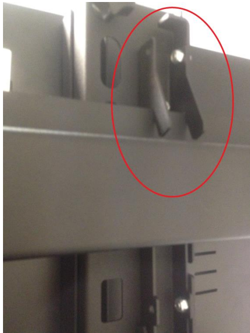
Рис.7 Навеска панели на верхнюю горизонтальную направляющую.
