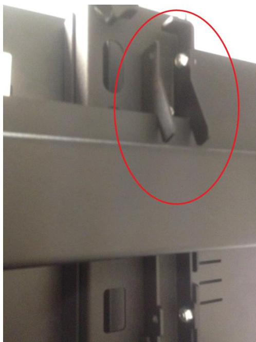
Рис.7 Навеска панели на верхнюю горизонтальную направляющую.
