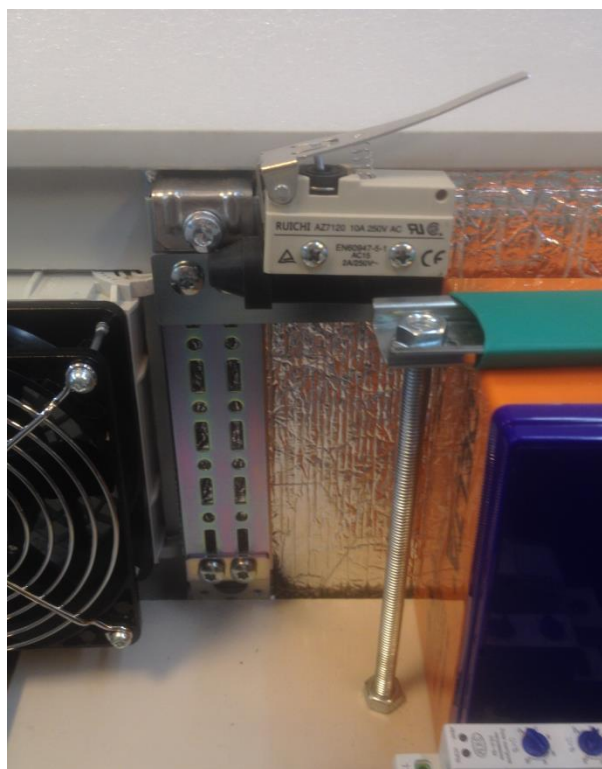
Рис.1-2 Установка датчика вскрытия в уличную станцию в пластиковом корпусе.
