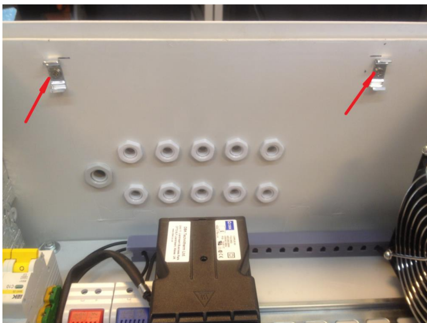
Рис.3.2.2-1 Установка пружинных креплений шкафа OSP.
