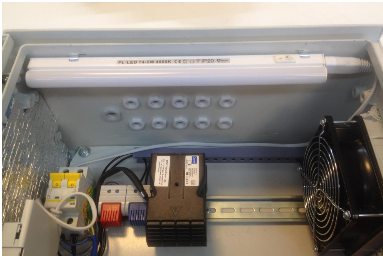
Рис.3.2.3-1 Светильник установленный в пружинные крепления шкафа OSP.
