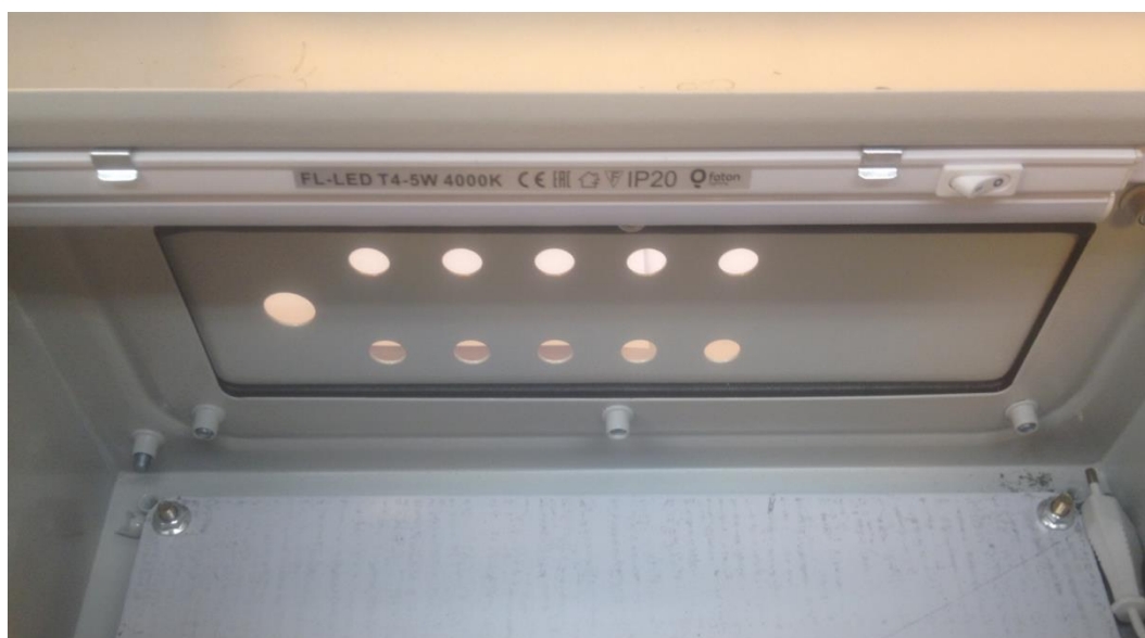
Рис.3.1.5-1 Установка светильника в корпус.
