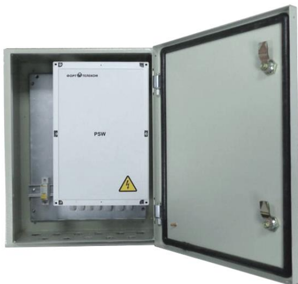
Рисунок 7.3 - Монтаж коммутатора в уличном шкафу.
